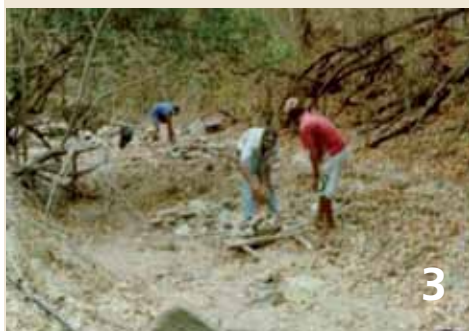
Foto 3 – Utilização da mão-de-obra local na construção dos microbarramentos.
