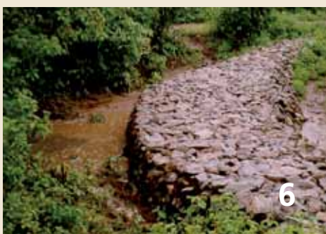
Foto 6 – Vista do microbarramento concluído com visão do acúmulo de água e o ressurgimento da vegetação herbácea espontânea do riacho.
